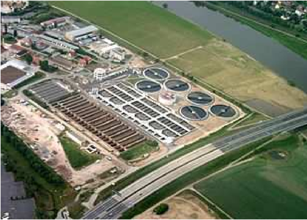
Impianto di depurazione delle acque reflue
