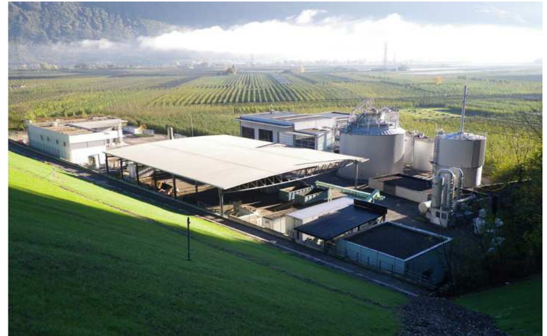
Impianto di compostaggio
